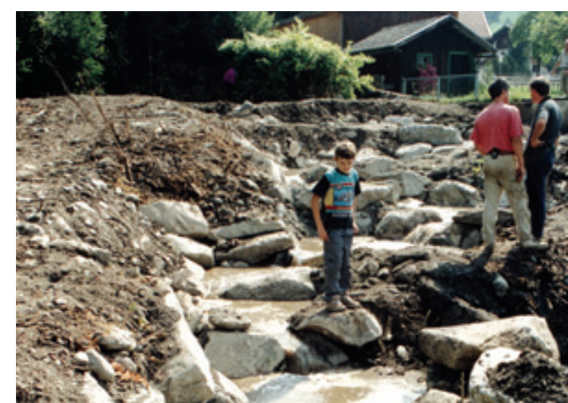
Bau einer Fischtreppe
