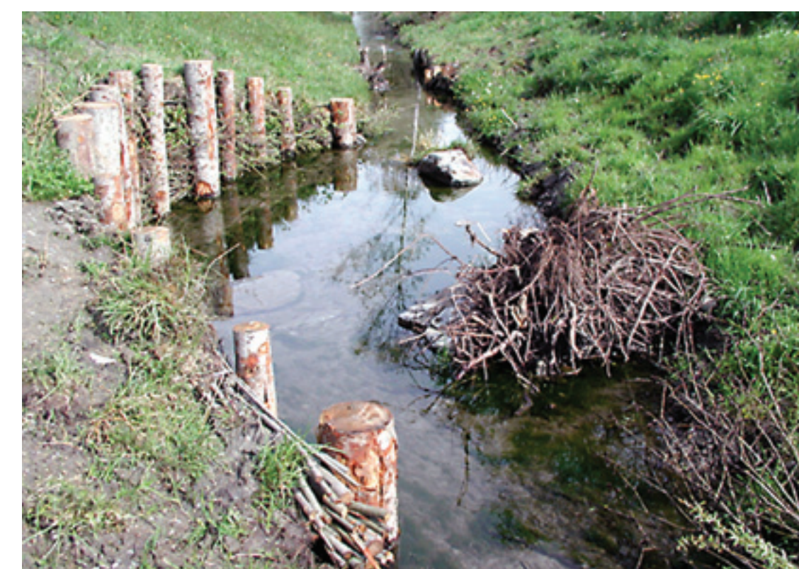
Faschinenwand zur Ufersicherung und Strukturierung
