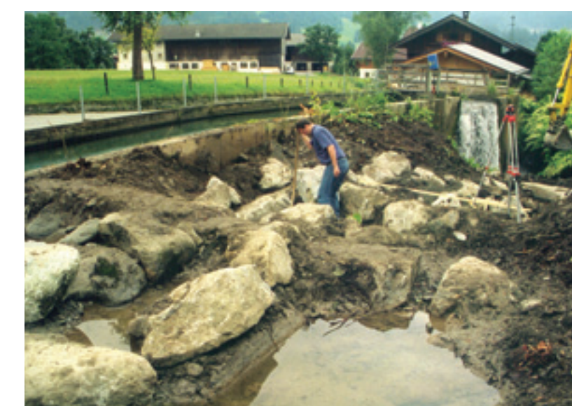
Bau einer Fischtreppe
